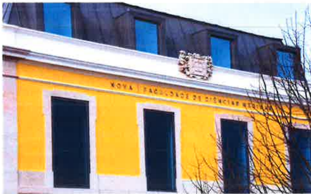
O Edifício amarelo do CEDOC-NMS|FCM
